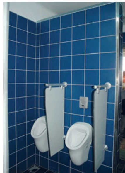
Fig. 4: Exemplo do equipamento interior de um banheiro em elementos pré-moldados, na Turquia
