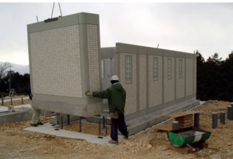
Figs. 2 e 3: Montagem dos elementos pré-moldados no canteiro de obras.
